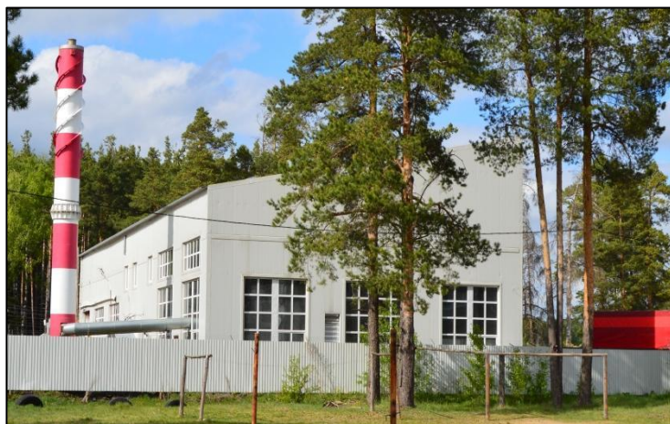
Котельная п. Андреево Владимирской области 3,0 МВт Топливо – фрезерный торф/брикеты Отпуск тепла – 5 040 Гкал/сезон Потребление топлива – 2 900 т/сезон
