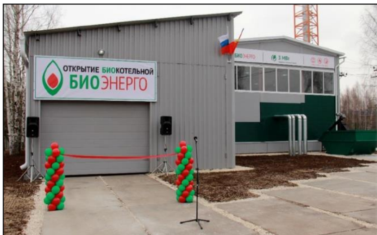
Котельная п. Тургенево Владимирской области 3,0 МВт Топливо – фрезерный торф/брикеты, щепа/уголь Отпуск тепла – 3 168 Гкал/сезон Потребление топлива – 2 300 т/сезон
