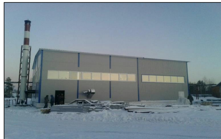
Котельная п. Мургреевский Ивановской области 3,0 МВт Топливо – фрезерный торф/щепа Отпуск тепла – 5 100 Гкал/сезон Потребление топлива – 3 500 т/сезон
