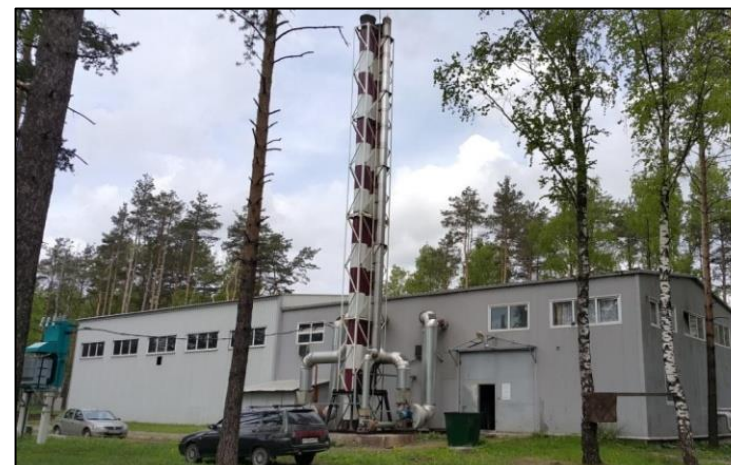
Котельная п. Ликино Владимирской области 3,3 МВт Топливо – фрезерный торф Отпуск тепла – 4 565 Гкал/сезон Потребление топлива – 3 200 т/сезон
